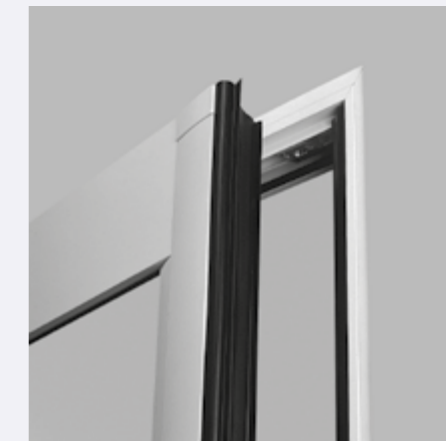
Détail sur version anti-pince doigts
