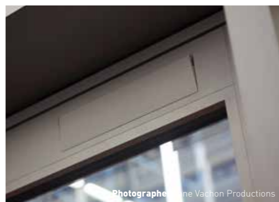
Trappe d'accès pour maintenance
