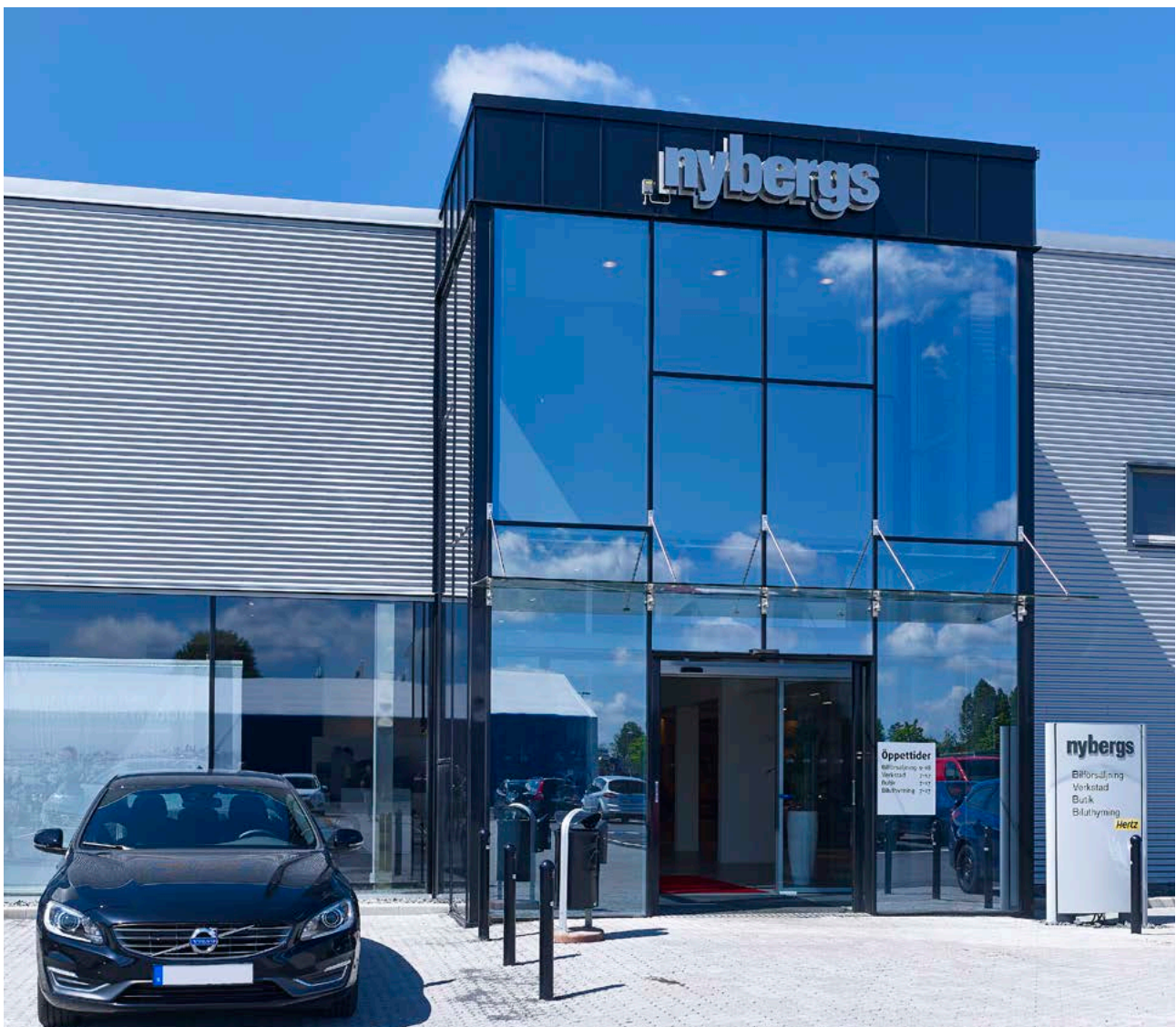
Optima 42844 med täcklock 42863 ger en smal exteriör profilbredd.
