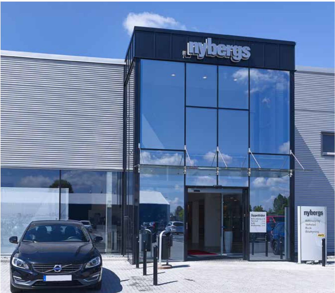
Optima 42844 med dekklokk 42863 gir en smal utvendig profilbredde.
