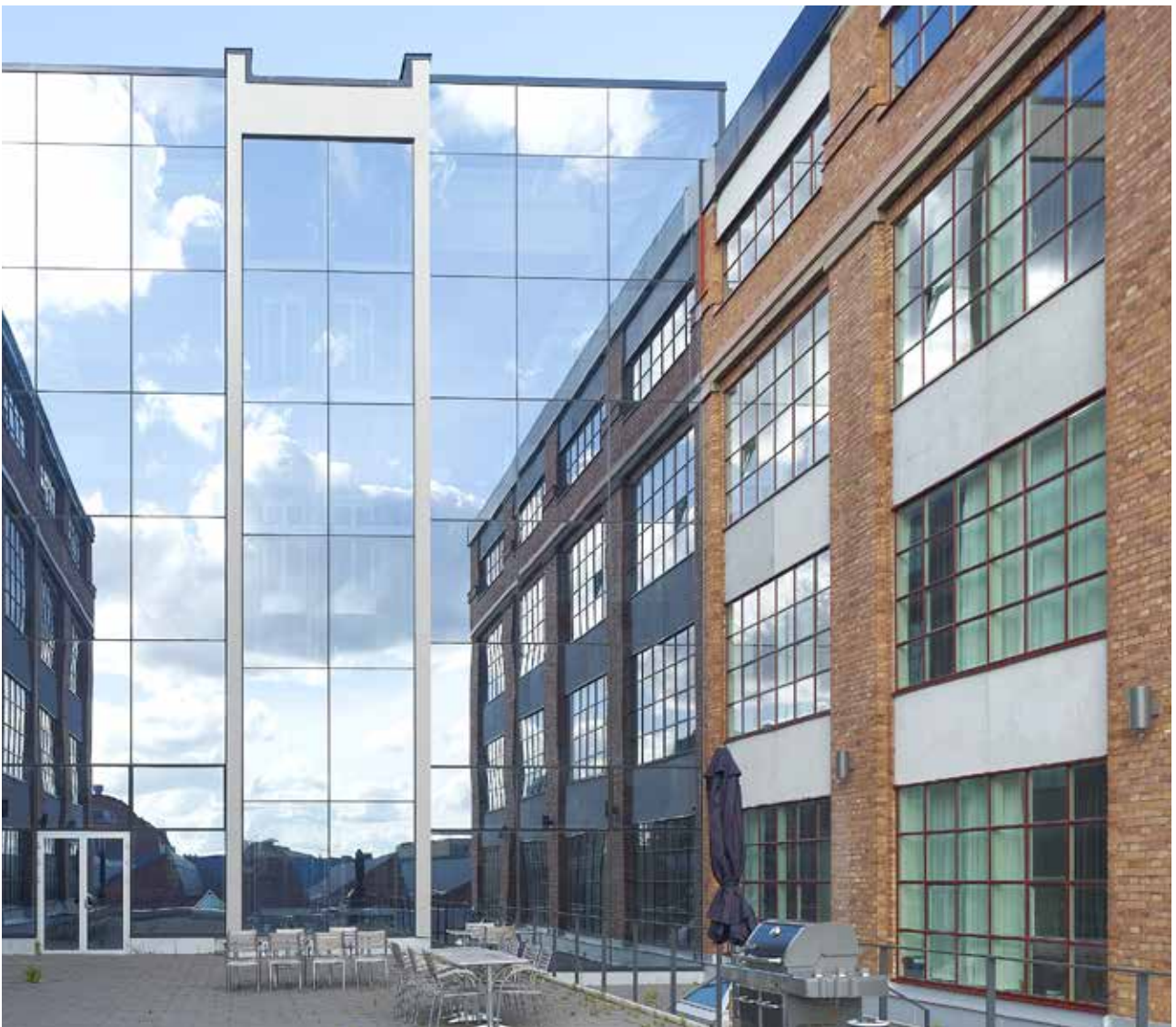
Julkisivujärjestelmä 4150 SSG AGA:lla Lidingössä, Tukholmassa.
