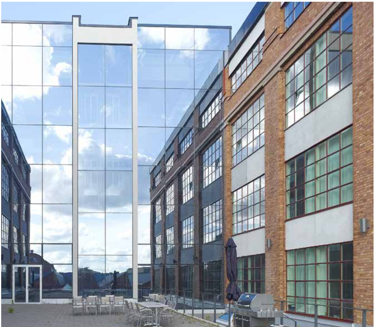
Fasadesystem 4150 SSG på AGA-verket på Lidingö, Stockholm.
